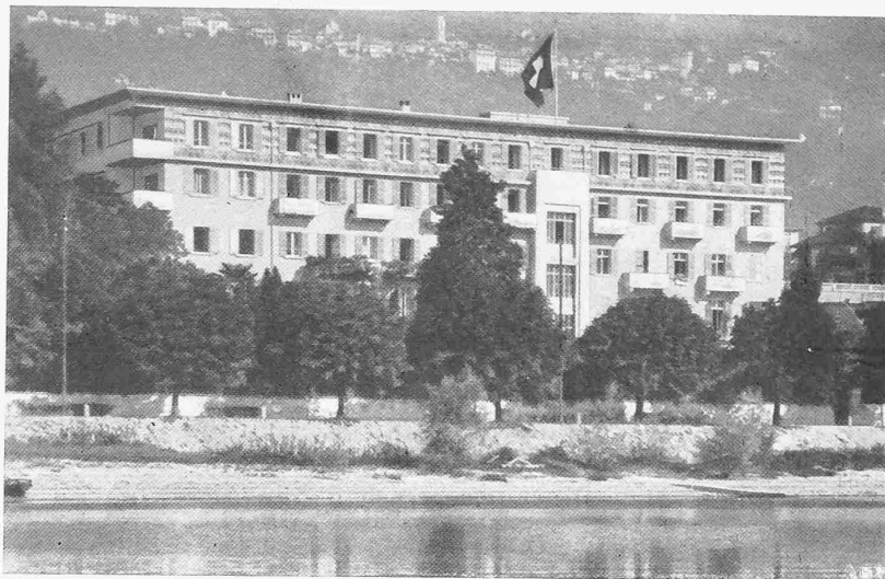
Abb 8. Um- und ausgebautes Hotel Reber in Locarno. Arch. A. Meili, Luzern.
