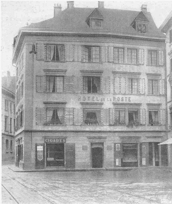
Abb. 1. Hotel Post in Luzern, alter Zustand.
