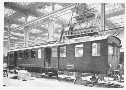
Abb. 4. Einbau des Dieselmotoraggregates in den Triebwagen.
