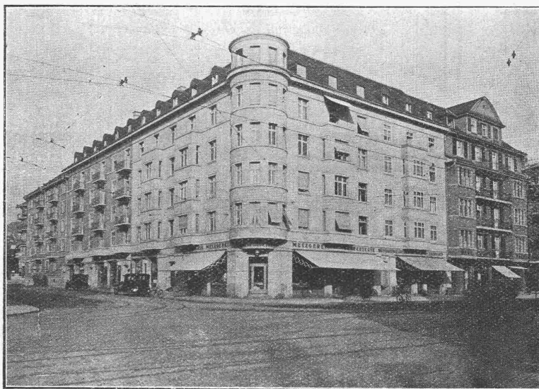
Geschäfts- und Wohnhäuser am Kreuzplatz in Zürich 7.
