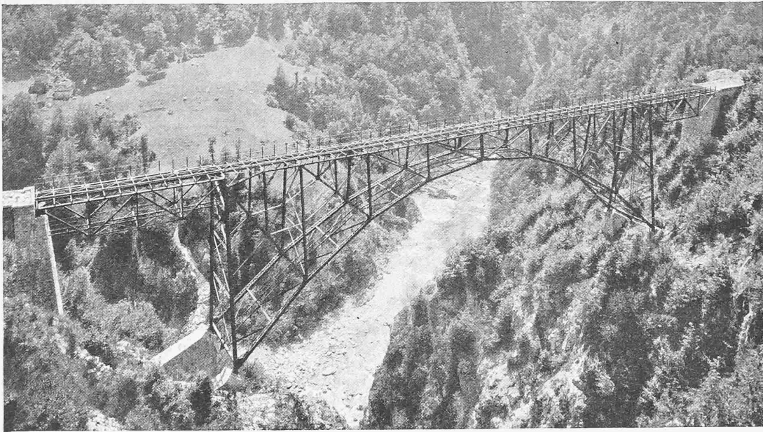
Abb. 8. Ruinacci-Brücke bei Camedo (nach Vollendung der Eisenkonstruktion). Stützweite 65,920 m, Gefälle 3‰/100.
