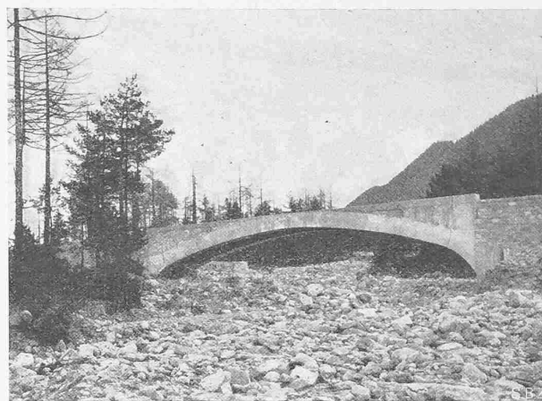
Abb. 17. Armierter Betonbogen über den Rivo Ragno.
