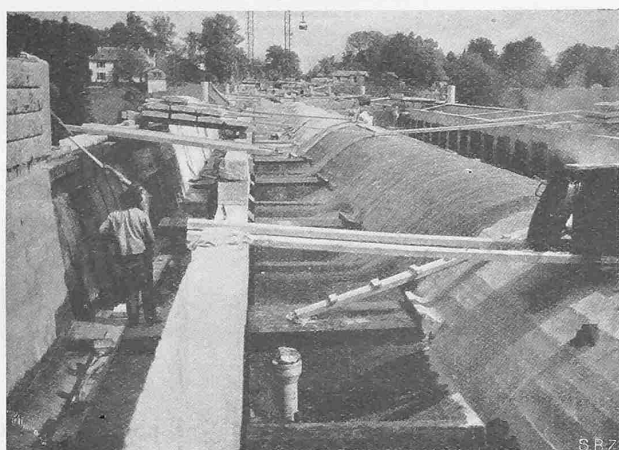
Fig. 23. Voûtes supérieures avant le remplissage.
