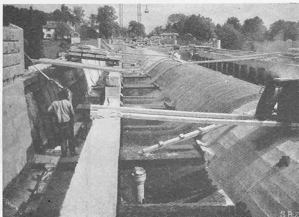
Fig. 23. Voûtes supérieures avant le remplissage.
