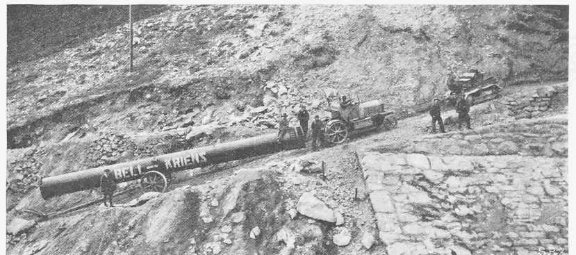
Abb. 78. Rohrtransport auf einer Steigung von 30%.
