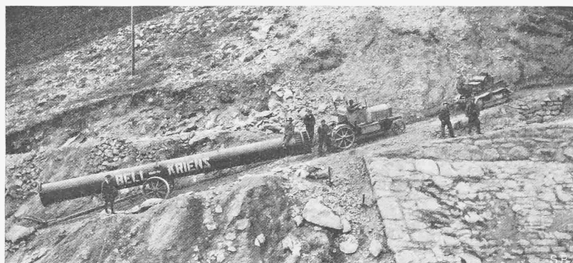
Abb. 78. Rohrtransport auf einer Steigung von 30%.
