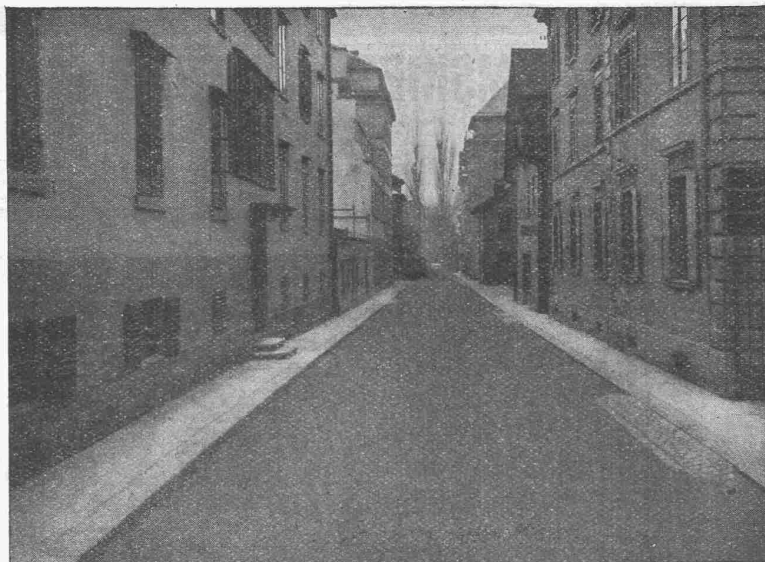
GLARNISCHSTRASSE ZÜRICH Walz-Asphalt: Topeka, 6 cm stark
