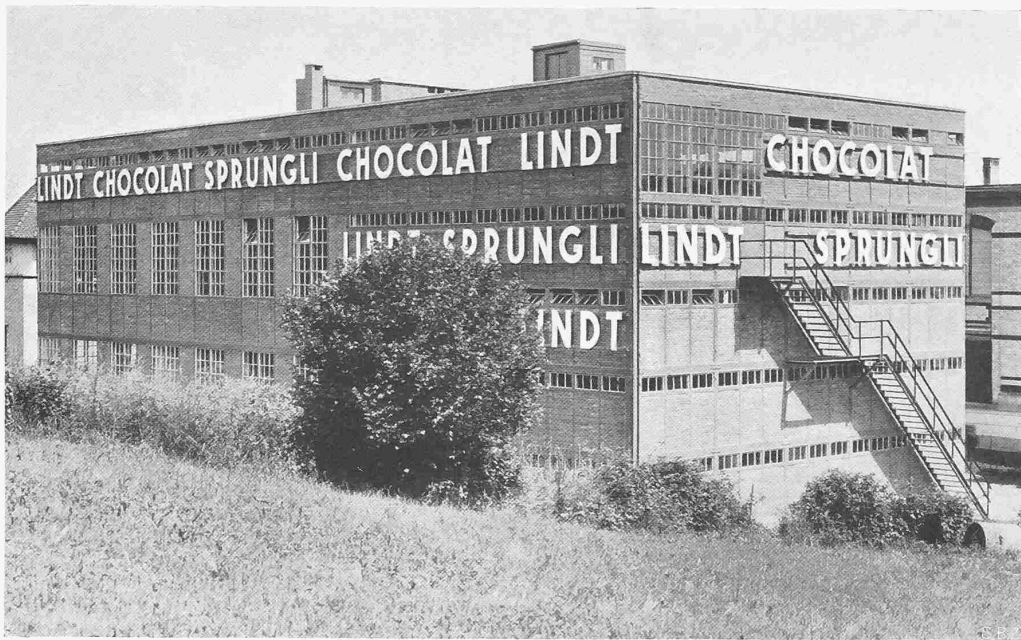
CACAO-LAGERHAUS UND -ROESTEREI IN KILCHBERG BEI ZÜRICH EISENSKELETTBAU VON W. KOCH & CIE., ZÜRICH AUSMAUERUNG IN ROTEM BACKSTEIN
