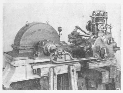
Abb. 22. 1500 PS-Turbine samt Regulator von Escher Wyss & Cie, Zürich.
