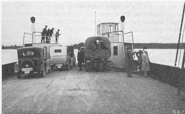
Abb. 2. Blick auf das Deck der Autofähre.
