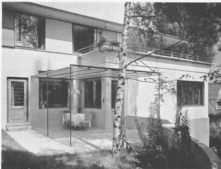
WOHNHAUS AM HALDENWEG IN KILCHBERG BEI ZÜRICH SITZPLATZ NEBEN DEM ESSRAUM
