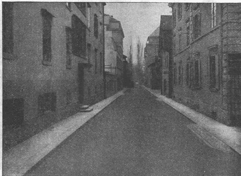
GLARNISCHSTRASSE ZÜRICH Walz-Asphalt: Topeka, 6 cm stark
