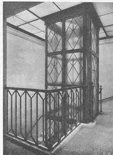
Abb. 14. Verglaster Aufzugschacht.
