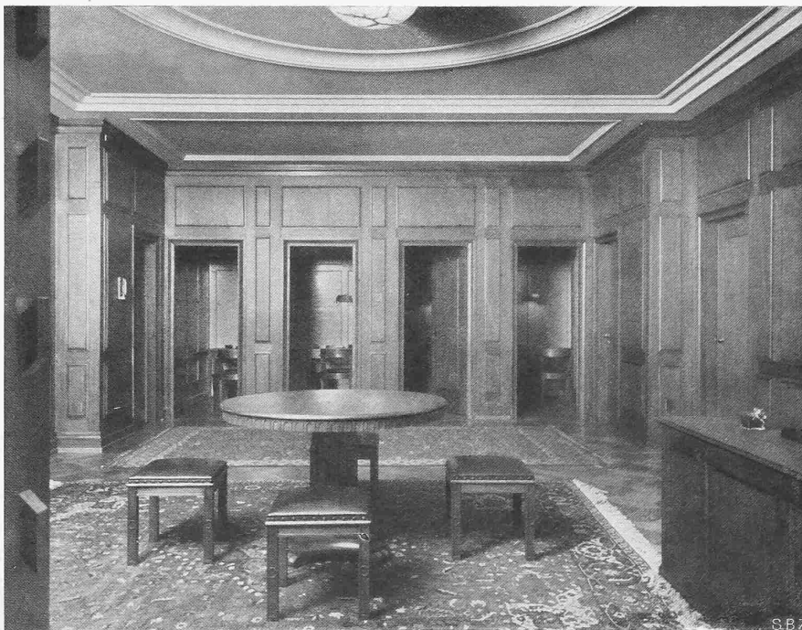
TRESOR-VORRAUM MIT KABINEN
