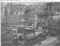
Kabelkran von 50 m Spannweite beim Hausbau Leistung 15 m<sup>3</sup>/h.
