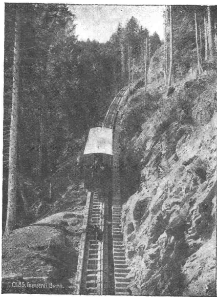
Seilbahn Niesen, I. Sektion, maximale Steigung 66 %.
