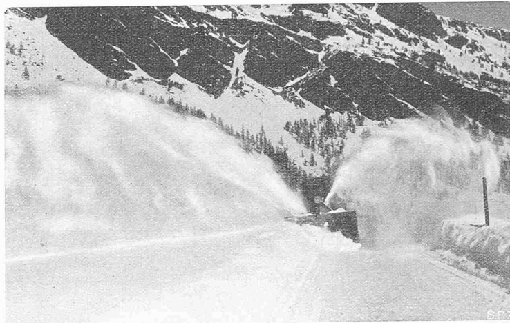
Abb. 5. Die Schneeschleudermaschine der schweiz. Postverwaltung an der Arbeit.
