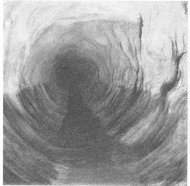
Abb. 25. Gunitierte unausgemauerte Stollenstrecke (Okt. 1922).
