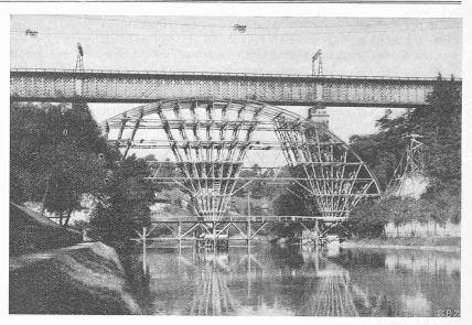
Das fertiggestellte Lehrgerüst für die Lorraine-Brücke über die Aare in Bern. (Hinter dem Lehrgerüst die Eisenbahnbrücke der S. B. B.)
