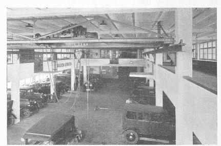
Abb. 21. Werkstatt mit Laufkran zur Galerie-Bedienung.
