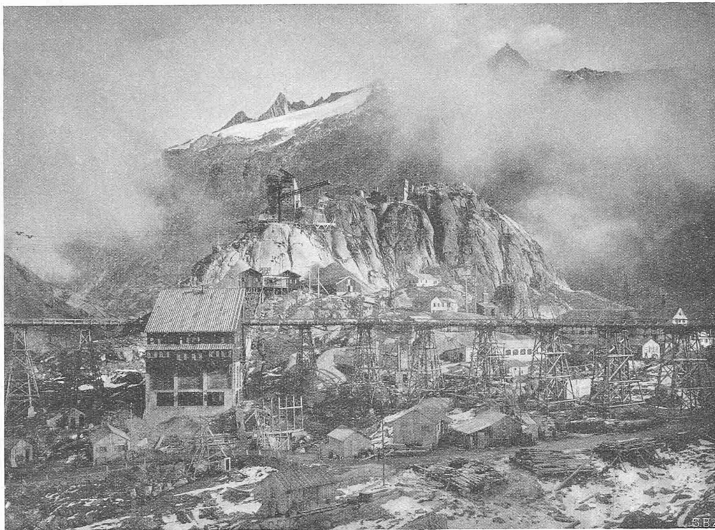
Abb. 5. Gesamtbild aus SW auf die Bauinstallationen am Nollen. Im Vordergrund der Viadukt der Kiestransportbahn, dahinter am Bildrand rechts das alte Grimsel-Hospiz. (Aufnahme 6. XI. 1927.)
