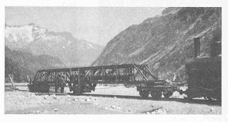
Abb. 3. Baggergeleise-Rückmaschine Arbenz-Kammerer.
