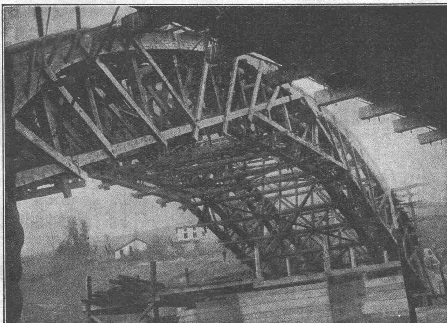
Lehrgerüst Pont d' Itxassou - 69,00 m Spannweite
