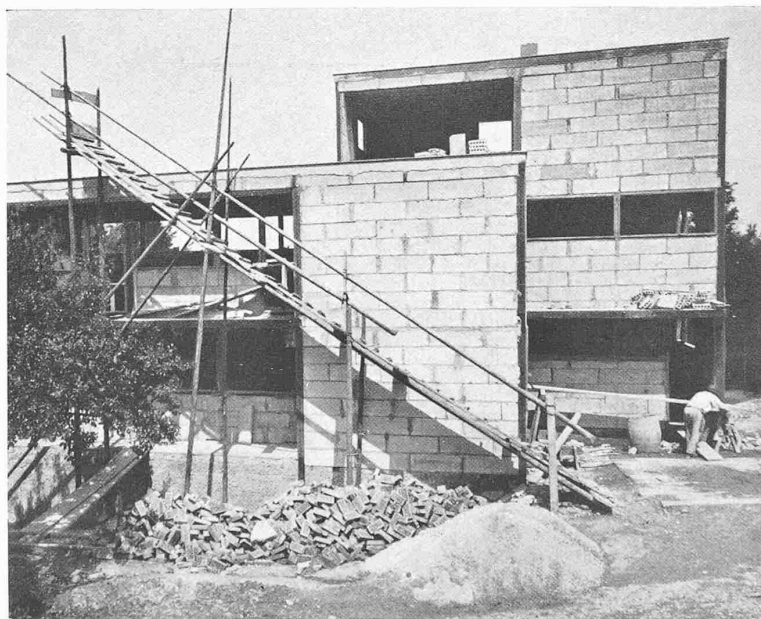
SÜDFRONT, IM BAU UND NACH VOLLENDUNG
