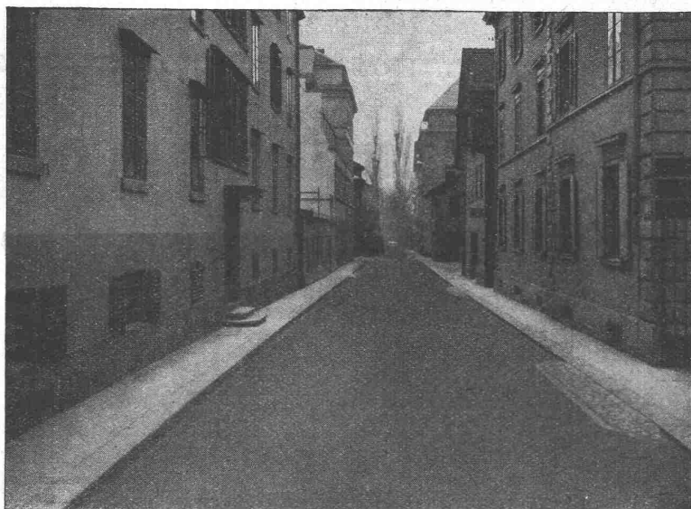
GLARNISCHSTRASSE ZÜRICH Walz-Asphalt: Topeka, 6 cm stark
