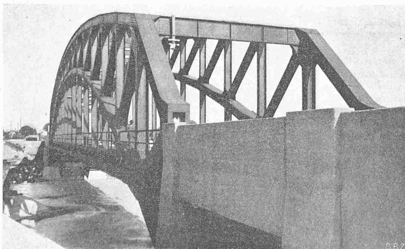
Abb. 1. Eiserne Eisenbahnbrücke über den Lech in Hochzoll bei Augsburg, Stützweite 91 m.
