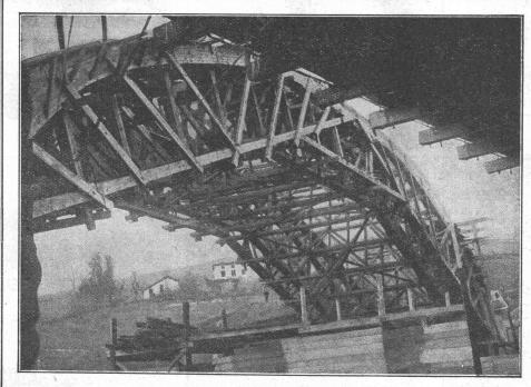
Lehrgerüst Pont d'Itxassou - 69,00 m Spannweite
