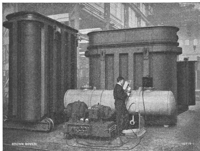
Mit Brown Boveri Lichtbogen-Schweißgruppen elektrisch geschweißte Groß-Transformatorenkessel.
