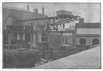
Hof-Laufkran, Tragkraft 15 Tonnen, Länge 23 m, mit einseitigem festen Ausleger.
