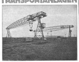
Fahrbare Brücken-Kabelkrane von je 55 m Spannweite, 5 t Tragfähigkeit und 2 m³ Kübelinhalt, beim Bau einer Kaimauer.
