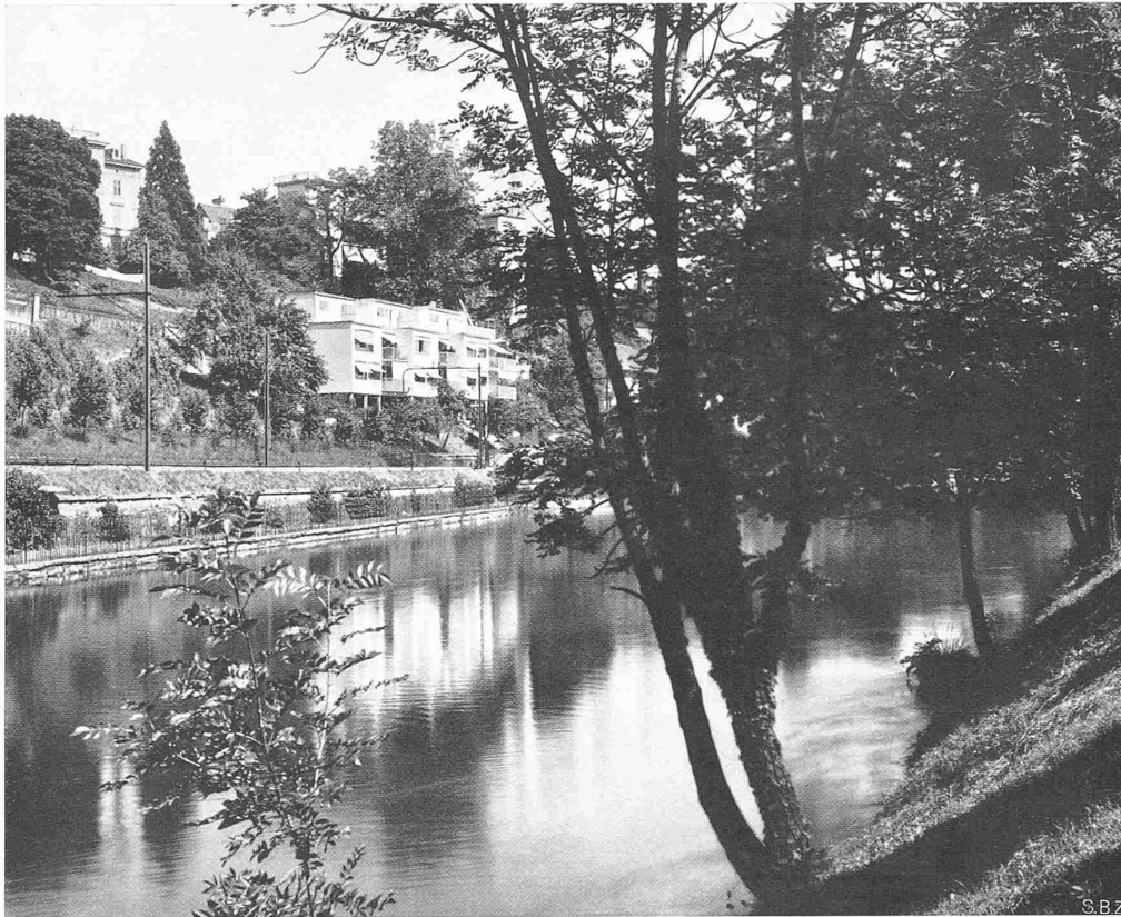
DIE „MUSTERHÄUSER“ AN DER WASSERWERKSTRASSE IN ZÜRICH ARCHITEKT MAX ERNST HAEFELI, ZÜRICH GESAMTBILD FLUSSAUFWÄRTS, VOM LINKEN UFER DES LIMMATKANALS
