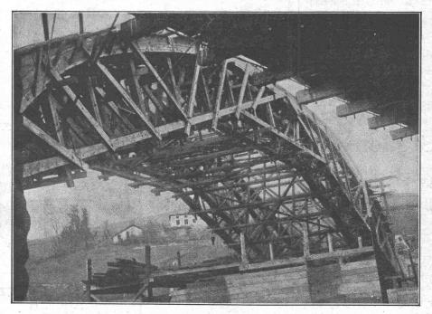
Lehrgerüst Pont d'Itxassou - 69,00 m Spannweite
