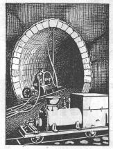
Zement-Injektionsmaschinen KESSELSCHMIEDE RICHTERSWIL
