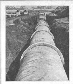
🕆 Patent (Armierte Betonröhren mit Muffen) Patent 🕆
