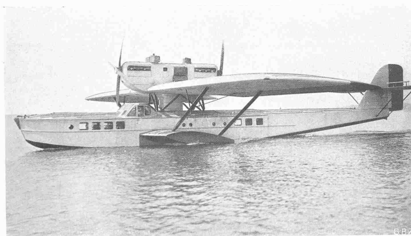
Abb. 29 bis 31. Dornier-Superwal mit zwei Rolls-Royce-Condor-Motoren von je 600 PS im Dienst der Deutschen Lufthansa auf den Linien Stettin-Oslo und Stettin-Stockholm.
