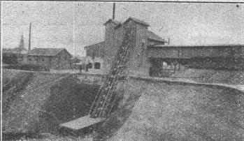
Stat. Kiesquetschwerk mit Grubenelevator.
