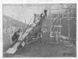
zum Fördern und Aufschichten von Zement in Säcken, Sand, Beton-gemisch, Kohle usw. Zum Ausschachten von Baugruben und zum Be- und Entladen von Wagen aller Art.
