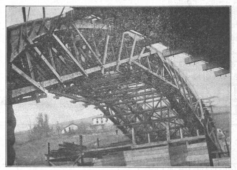
Lehrgerüst Pont d'Itxassou - 69,00 m Spannweite
