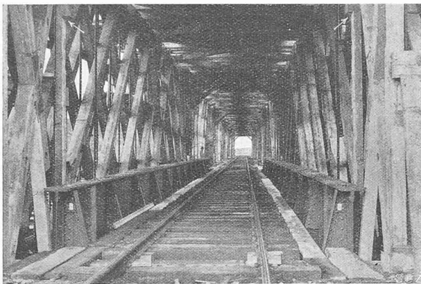
Abb. 25. Der erste eingelegte eiserne Ueberbau-Teil (84 t).
