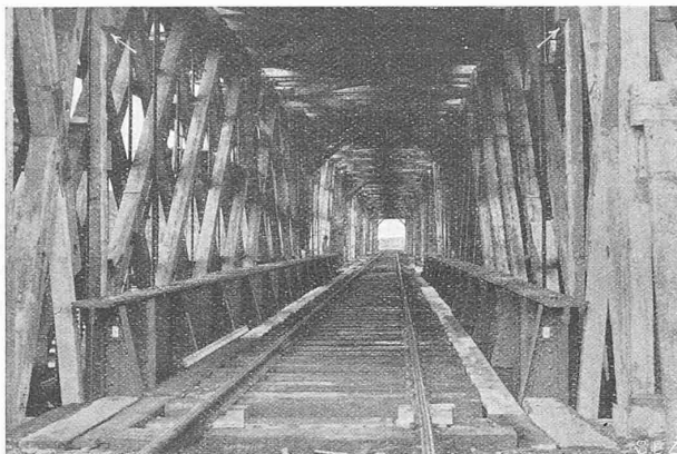
Abb. 25. Der erste eingelegte eiserne Ueberbau-Teil (84 t).
