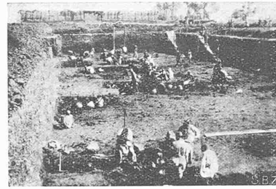
Abb. 4. Aushub und Transport von Hand für die Fundamente des Kraftwerkes Minieh (Aegypten).
