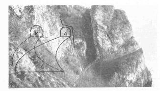
Abb. 33. Hinterfahrung des Sasso di Gandria, rechts der Fussweg. A Tunneleingang Antonietti bei Hm 16,70; V Variante etwa 30 m herwärts.
