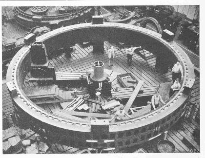
Stator eines vertikalachsigen Generators für das Conowingo-Wasserkraftwerk.
