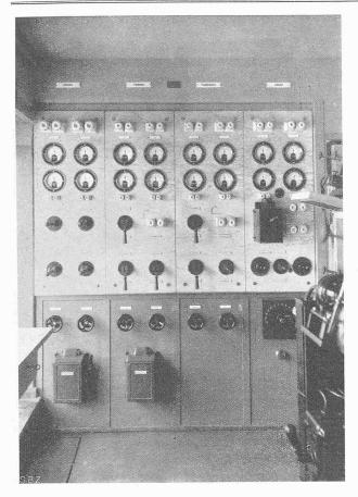
Abb. 28. Schalttafel der Kino-Operateur-Kabine.
