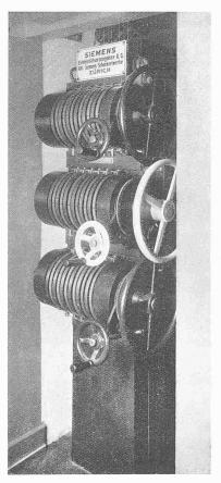
Abb. 26. Stellwerk für die Saalbeleuchtung.
