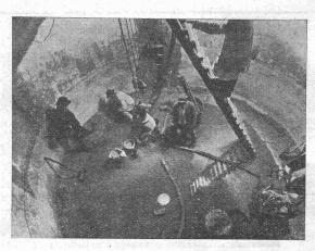
8 m tief im Grundwasser liegender Sammelbrunnen der Wasserwerke Hamburg, der mittels sehnellbindender "SIKA" gegen starke Wassereinbrüche abgedichtet worden ist.
