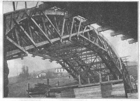
Lehrgerüst Pont d'Itxassou - 69,00 m Spannweite
