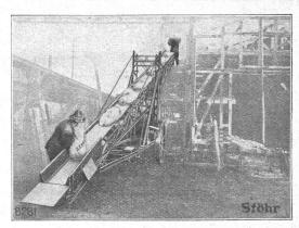
zum Fördern und Aufschichten von Zement in Säcken, Sand, Betongemisch, Kohle usw. Zum Ausschachten von Baugruben und zum Be- und Entladen von Wagen aller Art.
