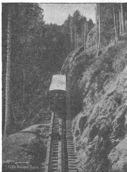
Seilbahn Niesen, I. Sektion, maximale Steigung 66 %.
