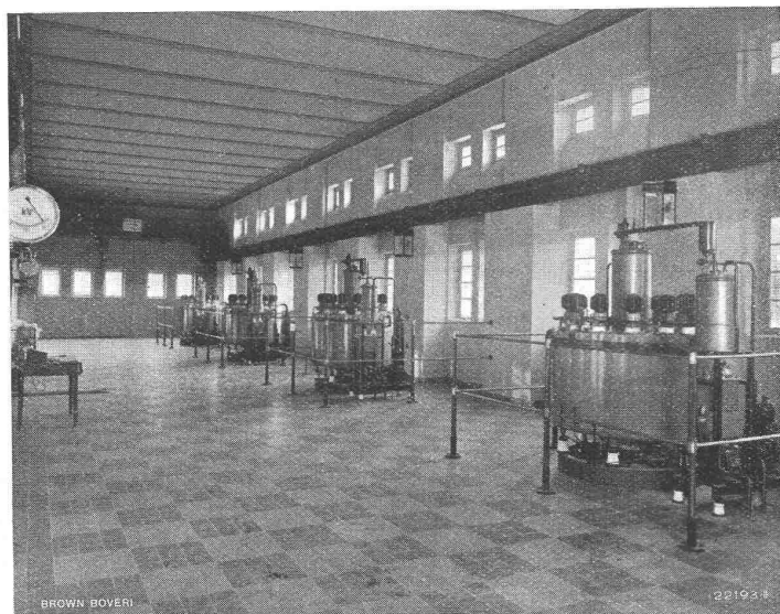
Gleichrichter-Unterstation Tegel der Deutschen Reichsbahn bestehend aus vier Gleichrichtergruppen zu je 600 kW bei 835 V Gleichstrom.
