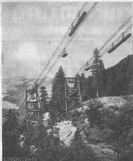
Drahtseilbahn „HECKEL“ zum Holztransport im Gebirge.
