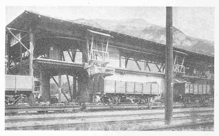
Abb. 17. Entladestation mit Normalspurwagen auf Rollschemeln.
