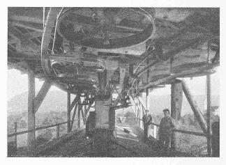
Abb. 13. Umlenkrollen der Winkelstation.
