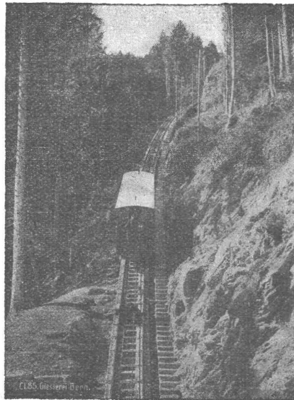
Seilbahn Niesen, I. Sektion, maximale Steigung 66 %.
