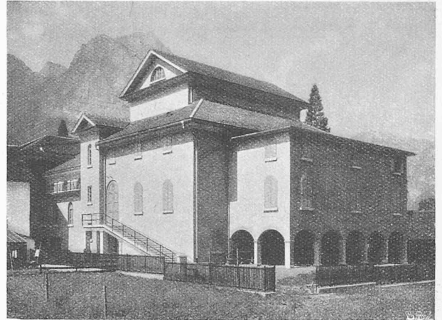
Abb. 5. Rückseite mit Bühnenanbau.
