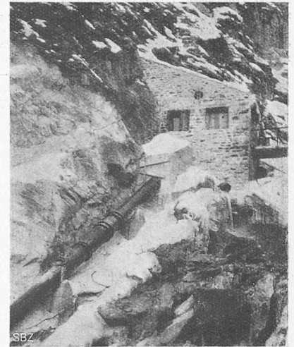
Abb. 8 und 9. Apparatenkammer, links 1:200. Rechts: Ansicht mit Austritt der 1. Druckleitung.
