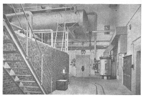
Elektroden-Dampf-Kessel- u. Speicher-Anlage im Frauen-Spital Basel. 6400 Volt Drehstrom 50 Perioden 2400 KW Std. Speicherleistung 1200 KW Kessel-
