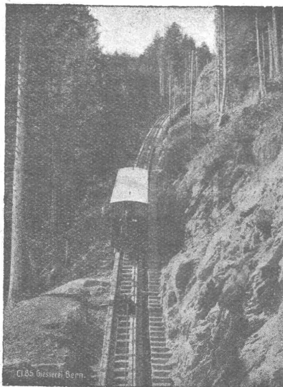
Seilbahn Niesen, I. Sektion, maximale Steigung 66 %.
