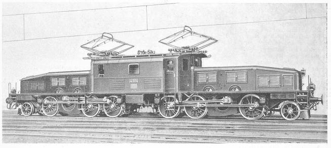
Abb. 1. Neue Einphasenwechselstrom-Güterzug-Lokomotive Typ 1 C C1 ( $Ce^{ij}$ ) der Schweizerischen Bundesbahnen. Gebaut von der Maschinenfabrik Oerlikon in Verbindung mit der Schweizer. Lokomotiv- und Maschinenfabrik Winterthur.
